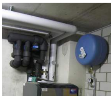
Fig. 5: Conduitture coibentate correttamente Fig. 6: Distributore della sonda geotermica corretto
