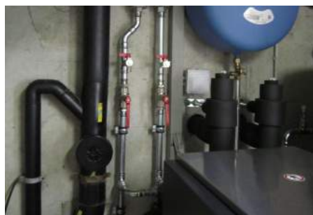
Fig. 1: Tubature non coibentate
