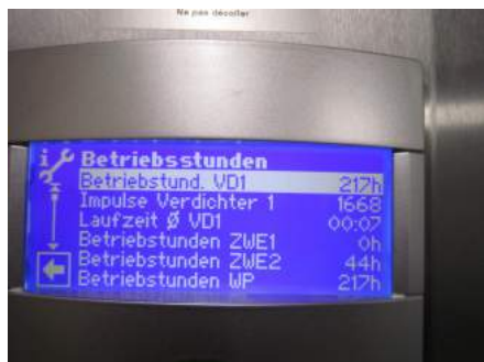
Fig. 3: Frequenza di accensione eccessivamente elevata dell'accumulatore
