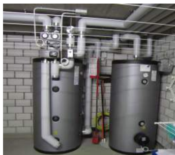
Fig. 4: Collegamento corretto
