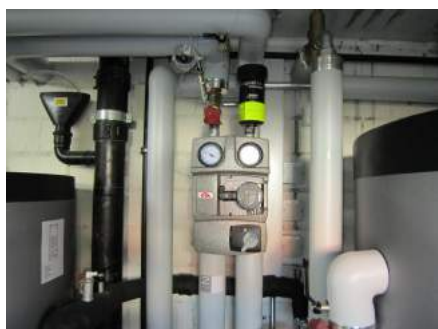
Fig. 5: Conduitture coibentate correttamente Fig. 6: Distributore della sonda geotermica corretto
