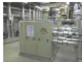
Nach der Sanierung: Neue Sole/Wasser-Wärmepumpe.
