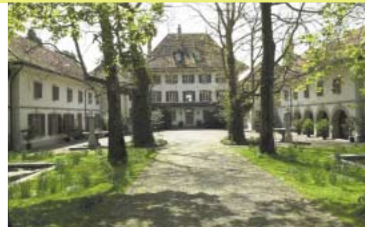
Auch beim Heizen setzt das Studienzentrum der Nationalbank auf Nummer sicher.
