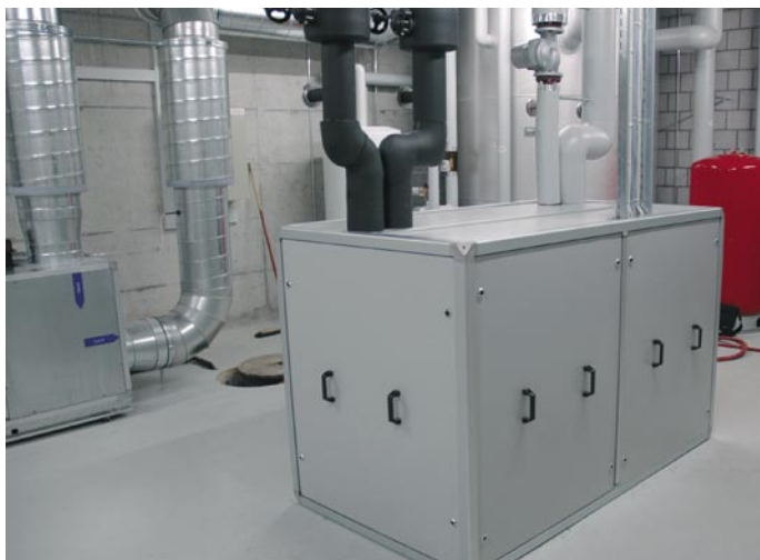
Auch grosse Wärmepumpen-Anlagen waren im letzten Jahr erfolgreich. Eine Wasser-Wasser-Wärmepumpe beheizt das neue MINERGIE-Gebäude der Firma Rotor Lips AG in Uetendorf. (Bilder: Informationsstelle Wärmepumpen, Bern)
